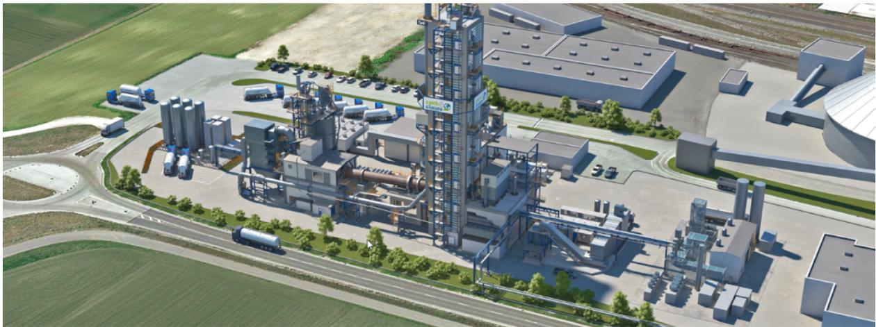
Abbildung 21: Darstellung der Oxyfuel-Anlage für das Demonstrationsprojekt „catch4climate“ in Mergelstetten.
