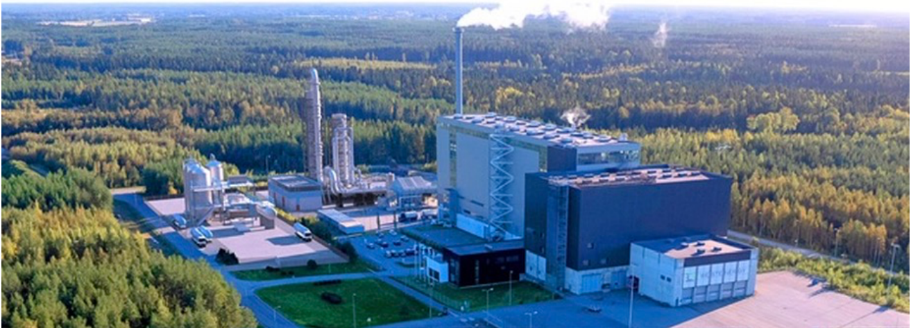
Müllverbrennungsanlage von Westenergy in Finnland mit CO 2 -Abscheideanlage
