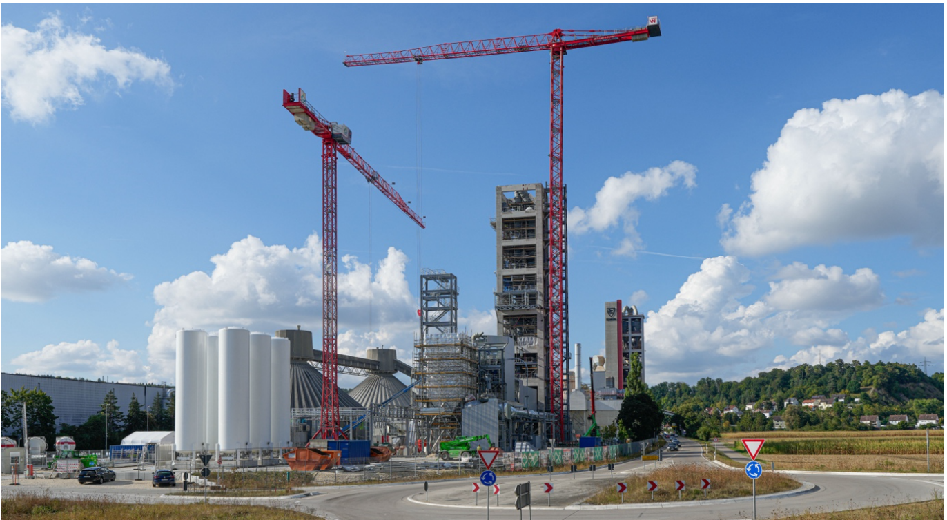
Versuchsanlage von Schwenk-Zement in Baden-Württemberg
